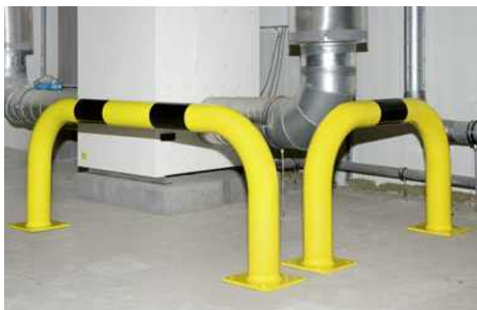
Rammschutz-Bügel XL mit Ø 108 mm und einer Wandstärke von 3,6 mm
